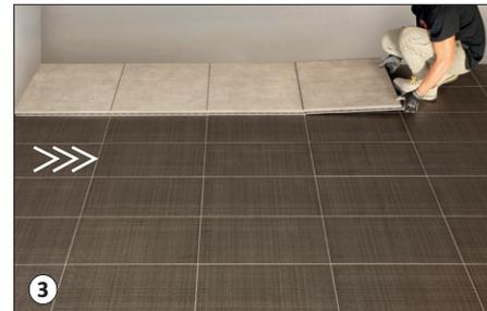
3 Bei der Verlegung von rechts nach links arbeiten, bis die Reihe vollständig ist.
