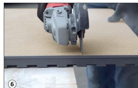
6 Zum Schneiden der Platten eine Fliesenschneidmaschine oder einen Trennschneider verwenden.
