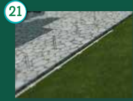
21. Fijar el perímetro de la instalación con grapaspada 50 cm
