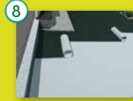
8. Extender la malla INTERDRAIN GMG 412
