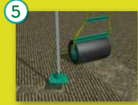
5. Compactar con un rodillo
