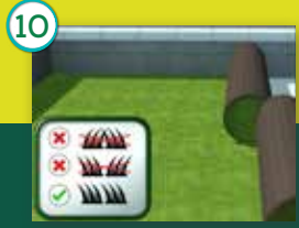
10. Colocar los rollos de césped, con el pelo en la misma dirección
