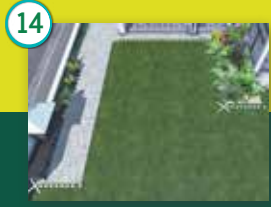
14. Fijar sólo un extremo de rollo de césped con grapaspada 50 cm
