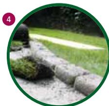
Überlappungen sind mit einem langen Messer leicht entfernbar und Reststücke überall an-setzbar, wo evtl. noch ein Teilstück fehlt.
