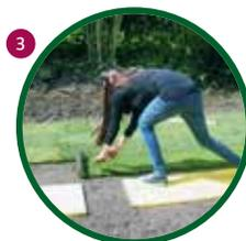
Verlegung der Bahnen an ihren langen Seiten dicht aneinander. Anfang und Ende der Bahn aber stets um ca. 30-50 cm versetzt.
