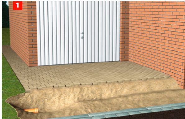
1. Rinnenstrangverlauf, Anschlusspunkt und Belastungsklasse festlegen.
