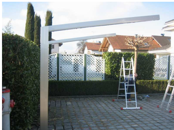
Bild 6: Montage der Dachträger
