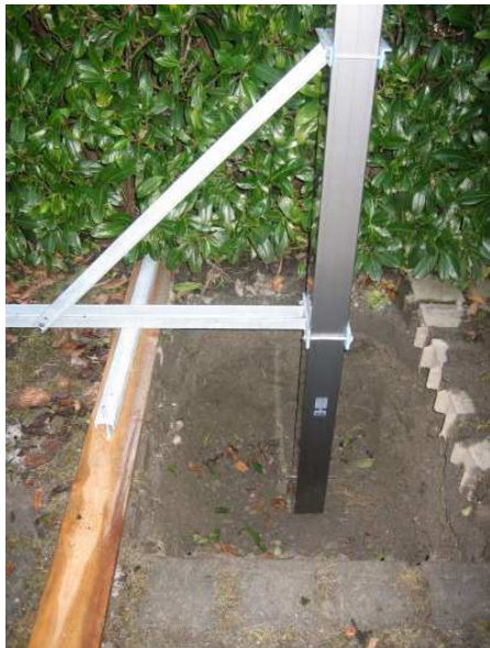
Bild 3 + 4: Beton einbringen und ca. 2 Tage aushärten lassen
