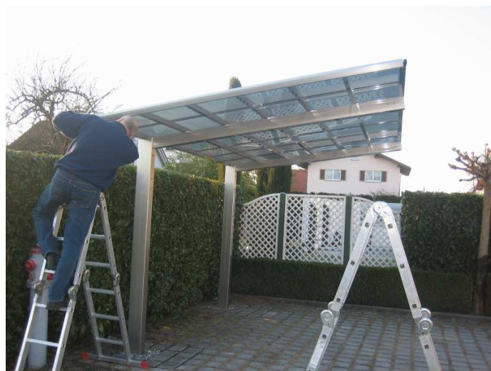
Bild 12: Montage der Abdeckungen
