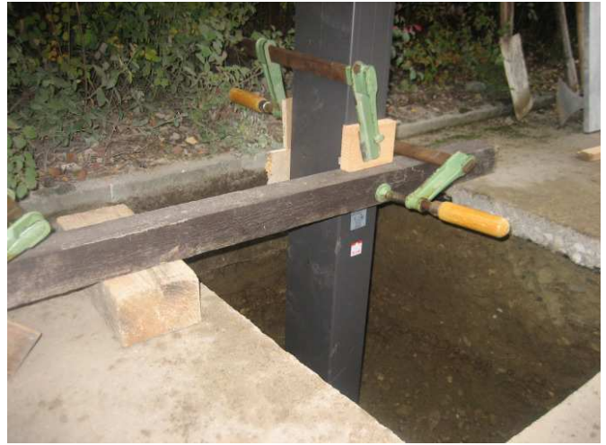
Bild 2: Positionieren der Bodenträger
