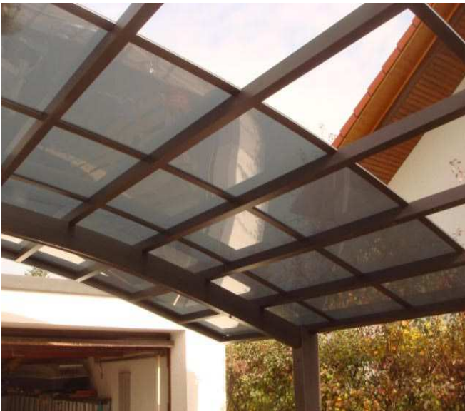
Bild 11: Montage der Abdeckungen
