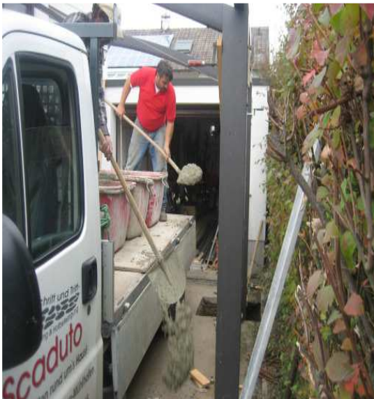
Bild 5 + 6: Beton einbringen und ca. 2 Tage aushärten lassen
