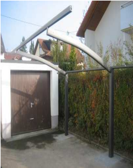
Bild 9 + 10: Montage der Querleisten
