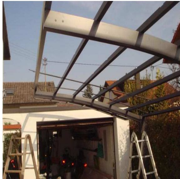
Bild 8: Montage der Längsleisten
