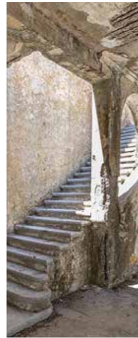
Lost Place - Stairway Prod. Nr. 27587469
