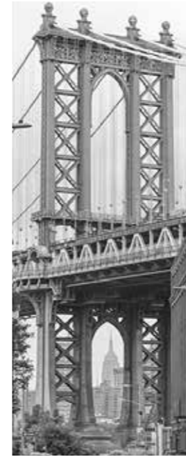
Old Bridge Prod. Nr. 27582747
