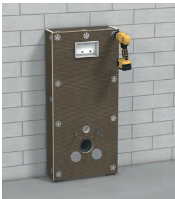
9.6 Montagetafel anschrauben
