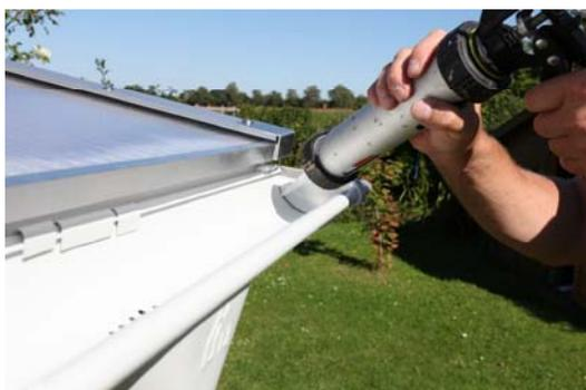
Nun bringen Sie an beiden Enden die Rinnenendstücke (C162-01/02) an (z.B. mit einem Gummihammer) und dichten diese mit Silikon ab.
