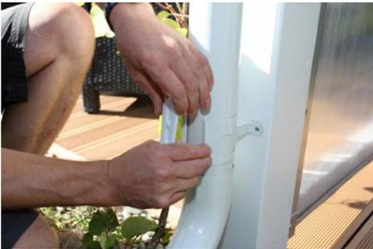
Schneiden Sie das Ablaufrohr (C165-200-01/02) auf die benötigte Länge und stecken Sie dieses mit dem unteren Auslauf (C168-01/02) zusammen, achten Sie darauf, dass die Naht jeweils nach vorne zeigt. Montieren Sie die untere Rohrschelle über der Steckverbindung zwischen Ablaufrohr und Auslauf mit je 2 Schrauben. Drücken Sie die Rohrschelle zusammen und schieben Sie den Klemmkeil (z.B. mit einem Holzstück) darüber.
