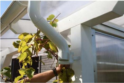
Schneiden Sie nun den Rohrverbinder (C167-01/02) auf die benötigte Länge zu. Achten Sie darauf, dass Rohr und Rohrbogen (C166-01/02) ausreichend weit ineinander stecken. Montieren Sie die obere Rohrschelle (C169-01/02) auf Höhe der Steckverbindung zwischen Rohrbogen und Ablaufrohr mit je 2 Schrauben.
