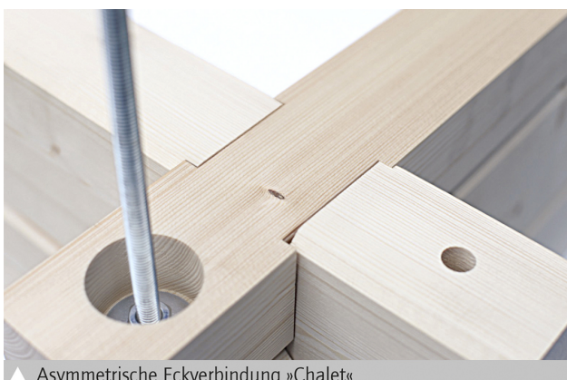
▲ Asymmetrische Eckverbindung »Chalet«
