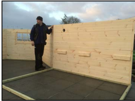
Wände auf Unterkonstruktion
