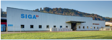
Werk in Schachen
