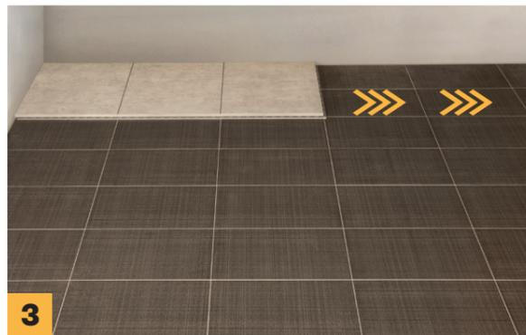
Die nächste Platte anlegen und festklicken. Bei der Verlegung von rechts nach links arbeiten, bis die Reihe vollständig ist.
