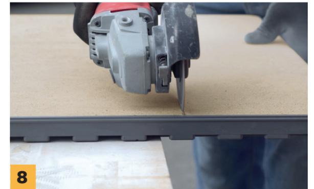
Zum Schneiden der Platten eine Fliesenschneidmaschine oder einen Trennschneider verwenden.
