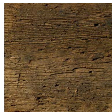
Originale Tennensboden Oberfläche
