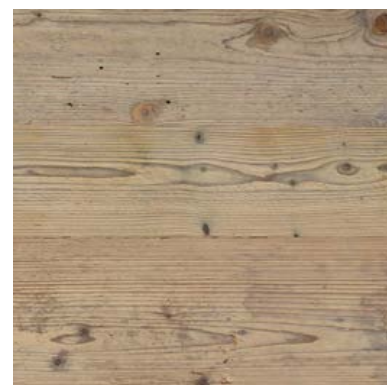
Originale Fußboden Oberfläche
