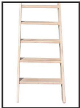
4. Zweite Wange mit Stufen verschrauben
