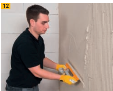
Abziehen der Armierungsschicht
