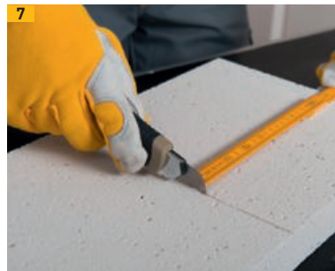
Passtücke können einfach mit einem Teppichmesser angerissen und geschnitten werden
