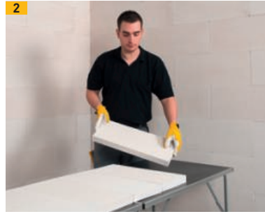
Zur schnellen Verarbeitung können mehrere Multipor WI compact plus Platten nebeneinander gelegt werden
