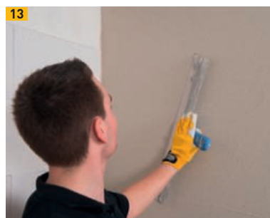
Glätten des Multipor Leicht- und Armierungsmörtels
