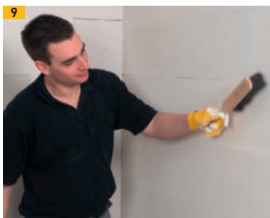
Anschließend Schleifstaub abfegen
