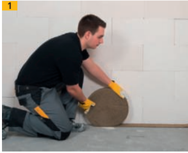
Zur Entkopplung wird der Multipor Hanf Filz-dämmstreifen auf dem Boden ausgerollt
