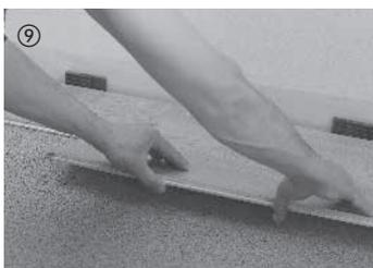
Die weiteren Elemente werden dielenweise verlegt. Dazu werden die Dielen zuerst längsseitig mit leichtem Druck in die Verbindung eingedreht.
