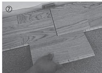
Grundsätzlich ist zur einwandfreien Verlegung der Elemente im Stirnbereich ein elementübergreifender Anchnitt im Längskantenbereich zu verwenden.
