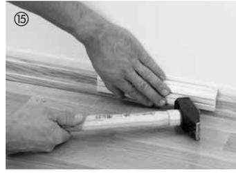
Nach der Verlegung unbedingt die Abstandskeile entfernen. Sockelleisten (mit und ohne Clip-System montierbar) werden an der Wand befestigt – fertig.
