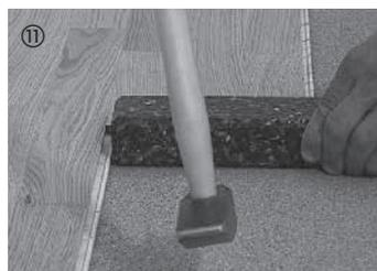
Anschließend wird das Element stirnseitig mit Hammer und Schlagklotz bzw. im Wandbereich mit Montageeisen mit dem rechts angrenzenden Element waagrecht zusammengeklickt.
