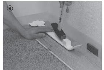
Das letzte Element der ersten Reihe wird, unter Berücksichtigung eines stirnseitigen Dehnungsabstandes von 10–15 mm zur Wand, zugeschnitten und mit dem Montageeisen eingefügt. Mit dem Reststück der ersten Reihe wird in der nächsten wieder begonnen. Dadurch wird der Verschnitt erheblich reduziert. Beachten Sie: stirnseitiger Versatz mindestens 50 cm.
