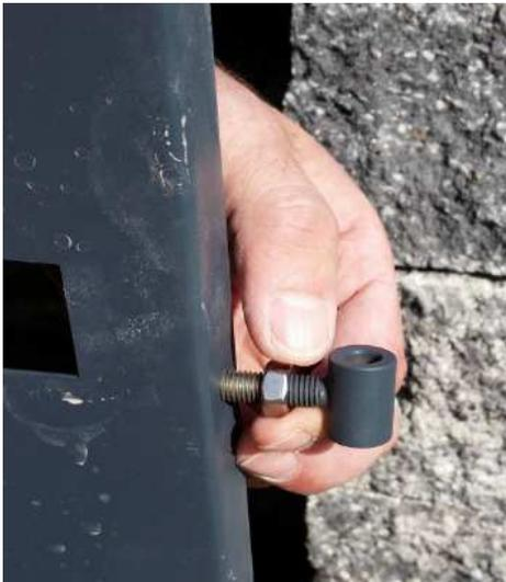
Montieren Sie die mitgelieferten Türaufhänger an den Türen. Gewinde bitte nur halb eindrehen und darauf achten das die Abstände (Gewindedrehungen) gleich sind.
