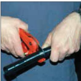
2 HDPE-Kaltwasserrohre mit Säge oder Schere für Kunststoffrohr rechtwinklig ablängen, Schnittkanten mit Feile entgraten und anfasen.
