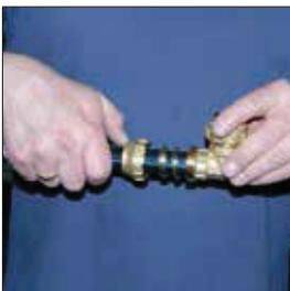
3 Überwurfmutter und Klemmring auf Rohrende aufschieben und das Rohr bis zum Anschlag in das Fitting einschieben, dabei Verschmutzung der Anschlüsse vermeiden.
