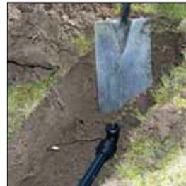
5 Bei Erdverlegung zum Schutz vor Beschädigung einen mindestens spatentiefen Graben ausheben.
