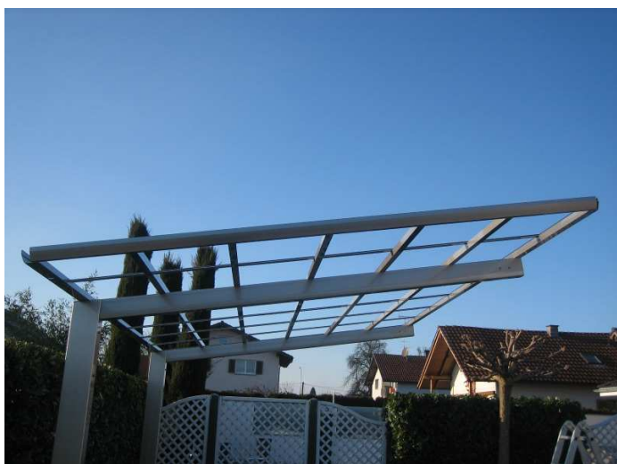
Bild 11: Montage der Querleisten
