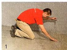
Als Dampfbremse wird eine Polyethylenfolie (PE 0,2mm stark) ausgelegt. Die PE-Folie muss 20-25 mm überlappen.
