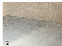
Über diese PE-Folie wird Elastilon (Schutzfolie nach oben) quer zur Verlegerichtung der Massivdielen/ Parkett ausgerollt. Die Elastilonbahnen dürfen nicht überlappen.
