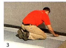
Schutzfolie bei Montagebeginn auf ca. doppelte Dielenbreite abziehen. Die Klebeschicht ist jetzt sichtbar.
