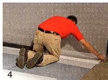
Eine Hilfsfolie\* doppelt falten und mit der Faltseite zur Wand sorgfältig auf die freigelegte Klebeschicht auflegen.
