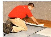
Die 2. Dielenreihe/Parkett mit der ersten Reihe verbinden. (Schlagklotz) und anschließend die Hilfsfolie zwischen dem Elastilon und den Parkettdielen hervorziehen. Nunmehr wird mit der eigentlichen Elastilonschutzfolie weitergearbeitet.
