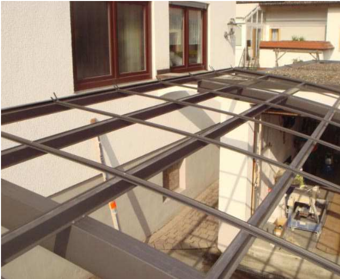
Bild 9 + 10: Montage der Querleisten
