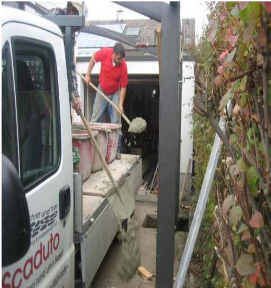
Bild 5 + 6: Beton einbringen und ca. 2 Tage aushärten lassen
