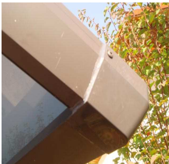
Bild 14: Montage und Abdichtung der Ecken
