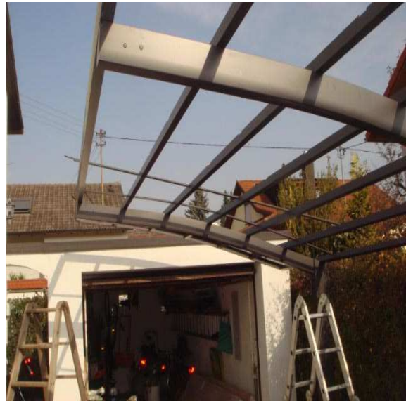
Bild 8: Montage der Längsleisten
