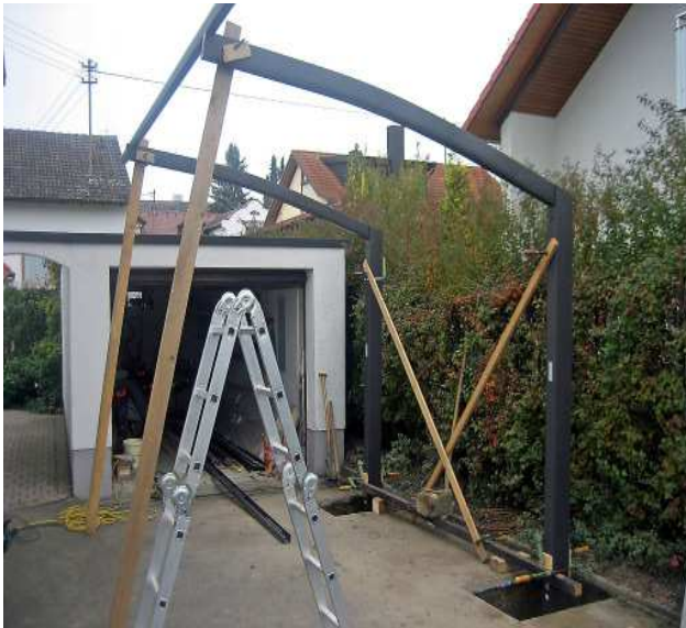
Bild 5 + 6: Beton einbringen und ca. 2 Tage aushärten lassen
