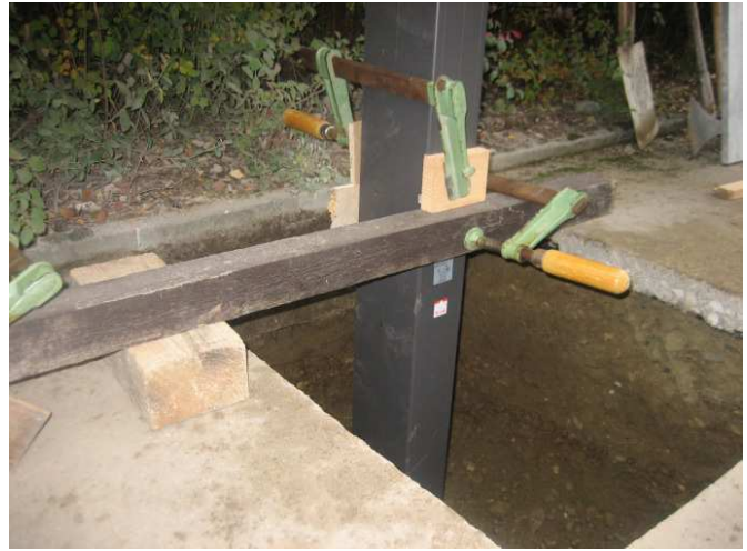
Bild 2: Positionieren der Bodenträger
