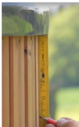
Abbildung 18: Lieferumfang, Markierung der Montageposition der Oberkante der Regalhalter, Positionierung des Regalbretts
